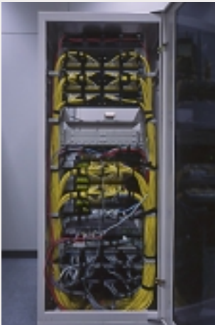
サーバとディスクレスPCをつなぐデルのネットワークスイッチ「PowerConnect」
